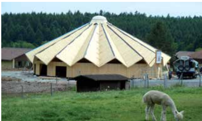
Das neue Circushaus im Bau-Fertigstellung im September 2012
